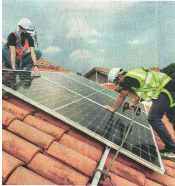
4 pekerja melakukan kerja-kerja pemasangan panel solar pada bumbung sebuah
