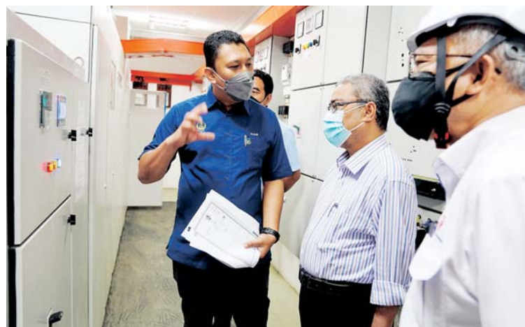
Rumaizi (dua dari kanan) mendengar penerangan di tapak Projek Solar PV di Bangunan UTC Ipoh.
