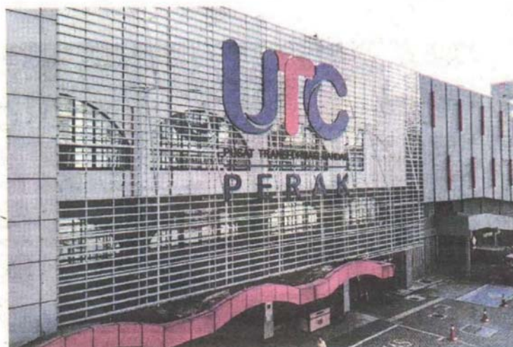
BANGUNAN UTC Perak terletak di Jalan Dato' Onn Jaafar, Ipoh.
