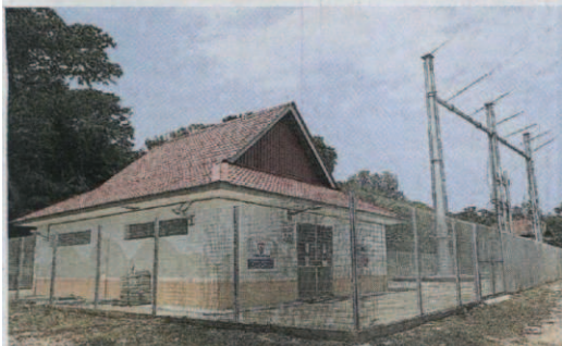
▲五屹岛上的电供转驳站，负责建设。将来自半岛的电供传输到岛上的。
