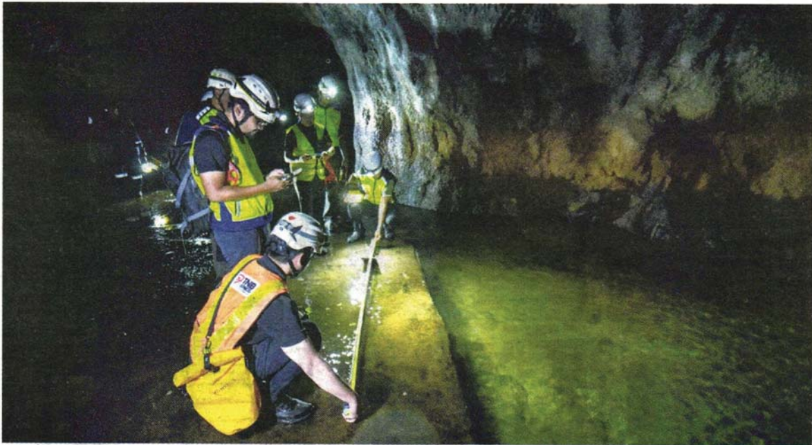
PASUKAN teknikal TNB membuat pemeriksaan dalam terowong Skim Hidroelektrik Ulu Jelai yang terletak di Pahang.
