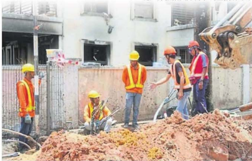
■以恢復居民正常用電。 國能工作人員正加緊更換受損的配電箱，
