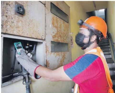
Pasukan Seal TNB memeriksa kotak meter utama yang dipintas di bawah premis.
