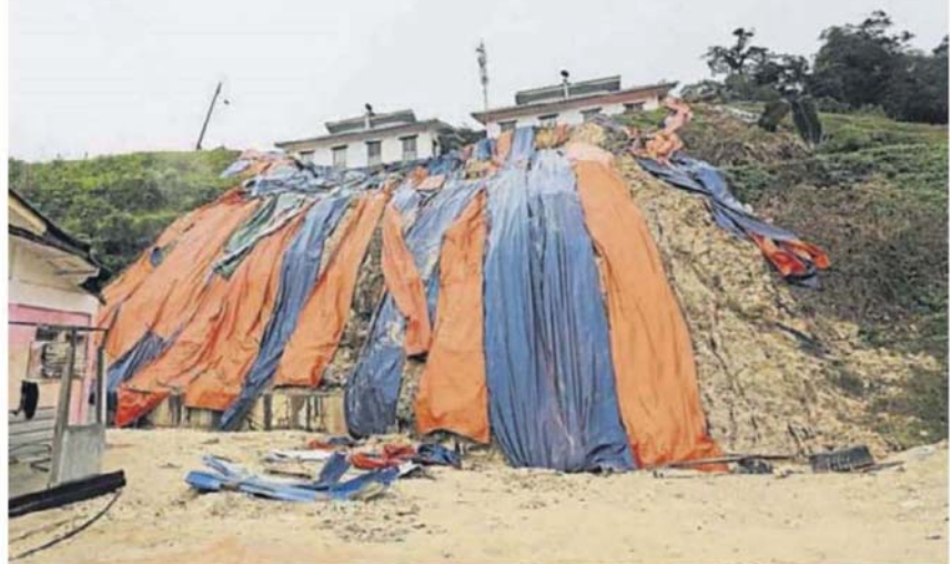
■去年10月12日,金马仑丹那拉打双溪瑞尔原住民村庄发生土崩事件。(马新社)
