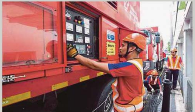
PENUGASAN tenaga kerja pelbagai peringkat bagi menjamin kestabilan bekalan elektrik menjelang sambutan Aidilfitri. - Gambar ihsan TNB
