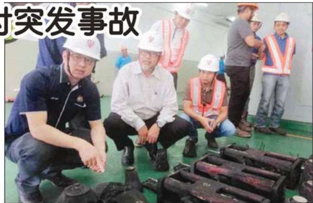
潘伟斯（前排左起）在峇德鲁山及柔州能源局官员陪同下，检查其中一部分发生爆炸的变压器。
