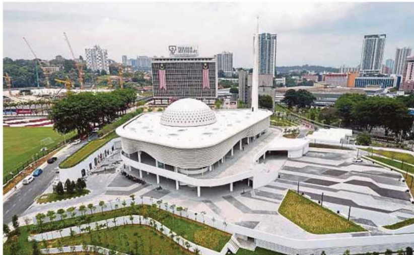
KOMPLEKS Balai Islam An-Nur memenuhi aspek Indeks Bangunan Hijau.
