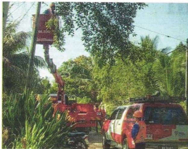
KAKITANGAN TNB melakukan kerja-kerja memotong bekalan elektrik di Kampung Baru Pulau Tiga, Sungai Layar, Lencongan Barat, Sungai Petani, Kedah. - UTUSAN/ABD. RAZAK OSMAN
