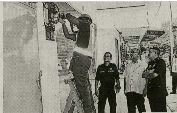
尼及查查利。 机中心的商店电表。右起诺再 国能在拆除一间被指是赌博
