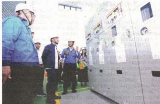
ONN HAFIZ Ghazi (tengah) diberi penerangan ketika melawat Pencawang Masuk Utama (PMU) sempena lawatan kerja berkaitan kemampuan penyediaan bekalan tenaga elektrik di PMU, Taman Kota Masai, Johor Bahru.
