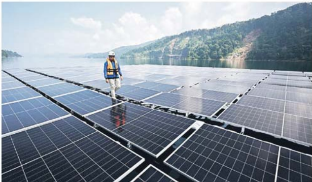
Projek perintis HHFS di Empangan Tasik Kenyir mempunyai kapasiti 100 kilowatt (kW) meliputi keluasan 1,085 m 2 dengan 220 panel solar.
