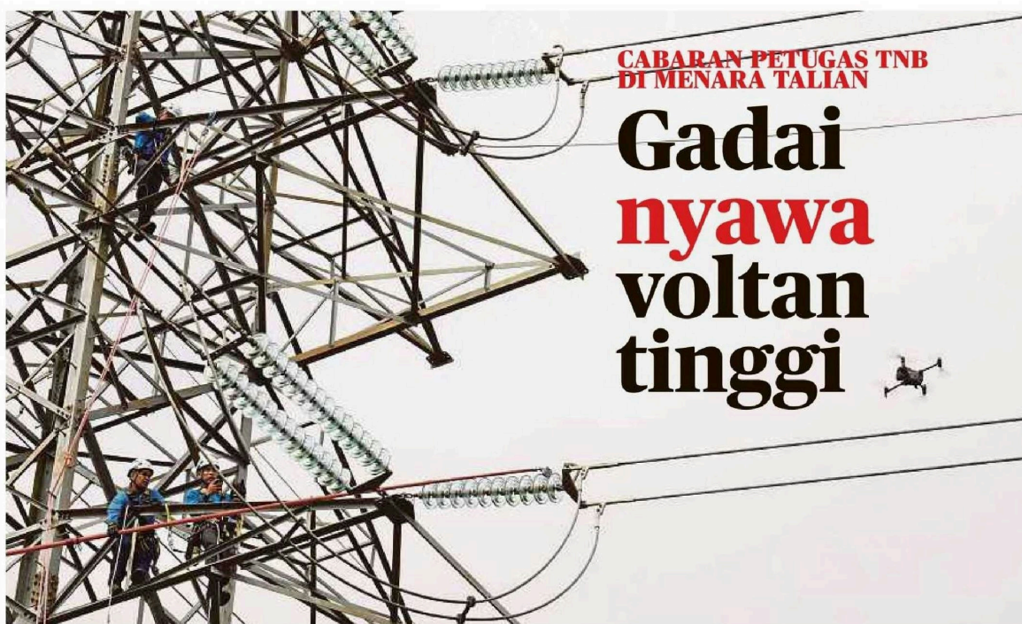
PASUKAN Grid TNB menjalankan kerja penyelenggaraan membabitkan talian bertvoltan tinggi. - Gambar NSTP/MUHAMMAD NAJMI NOR'AZAM
