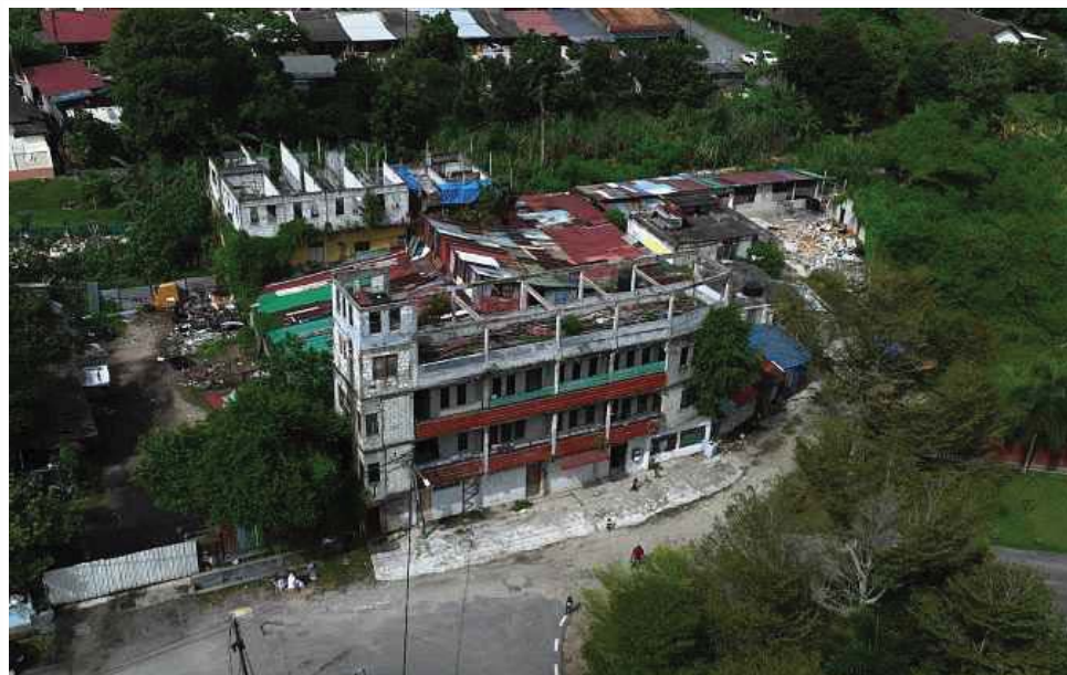
'FLAT' empat tingkat yang dibina secara tidak sah oleh komuniti Rohingya di kawasan terpencil di Sungai Tekali.
