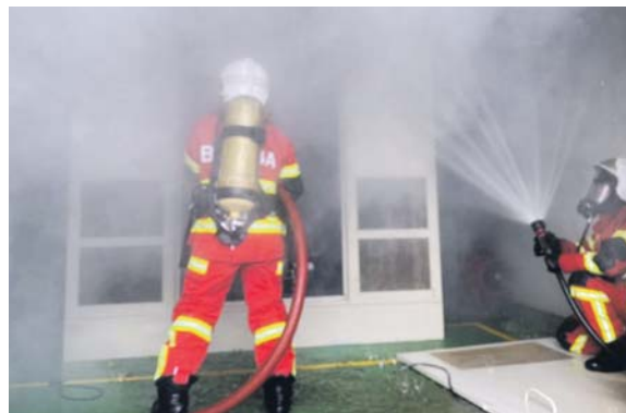
Anggota bomba melakukan kerja-kerja pemadaman kebakaran di sebuah bilik selepas dua transformers terbakar di Loji Air Semangar, Jalan Kulai-Kota Tinggi, Kota Tinggi pada Selasa.
