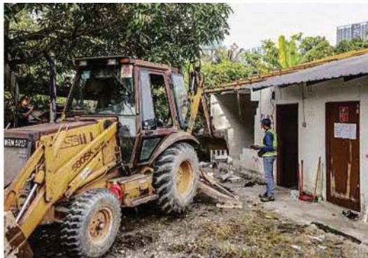
Operasi perobohan 68 kediaman dan binaan di Kampung Chubadak Tambahan, Sentul berjalan seperti dijadualkan, semalam.
