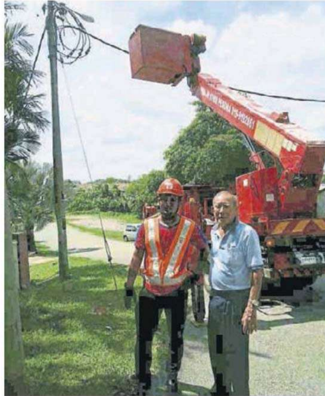
■ 郭明发（右）巡视国能维修失灵路灯工程。
