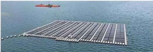
Tapak projek Pembangunan Solar Terapung Hidro Hybrid dan Hab Hidrogen Hijau Terengganu di Stesen Janakuasa Sultan Mahmud Kenyir, Kuala Berang.
