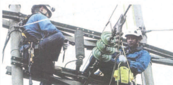
Pekerja mula memasang penebat kilat di Felda Sungai Tinggi.
