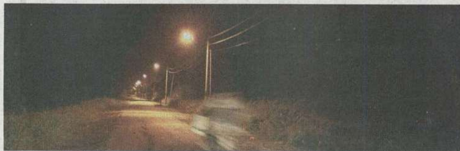
SALAH satu jalan kampung yang telah mempunyai lampu jalan melalui Program Pemasangan Lampu Jalan Kampung (LJK) yang telah lengkap sepenuhnya di negeri Johor.
