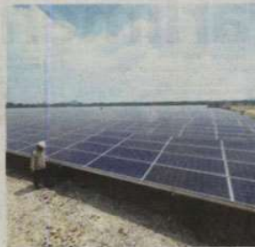
JURU Pendawaian Elektrik EPIC, Zainuddin Salleh memeriksa loji jana kuasa tenaga solar yang telah beroperasi.
