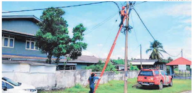
Kakitangan TNB Cawangan Kemaman sedang melakukan kerja-kerja pemotongan bekalan elektrik di rumah suspek yang dijadikan kedai runcit.
