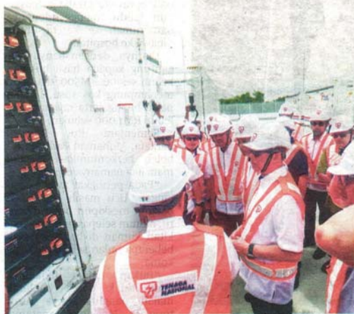
FADILLAH Yusof (dua, kanan) melawat tapak Sistem Penyimpanan Tenaga Bateri (BESS) Santong 100MW/400MWh di Santong, Paka, Terengganu. - UTUSAN/PUQTRA HAIRRY
