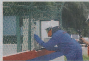
由于输电站拥有高压电流，授权人关闭电源时需全副武装。
