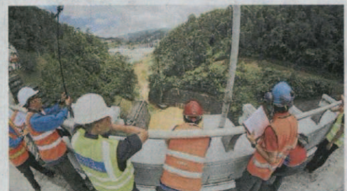
国能职员观察泄洪情况，也将泄洪过程拍摄记录。
