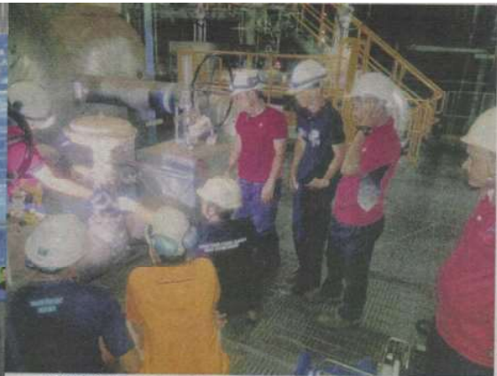
KEROSAKAN pada sistem kawalan injap pneumatik memerlukan tenaga yang ramai untuk dikesan secara manual.
