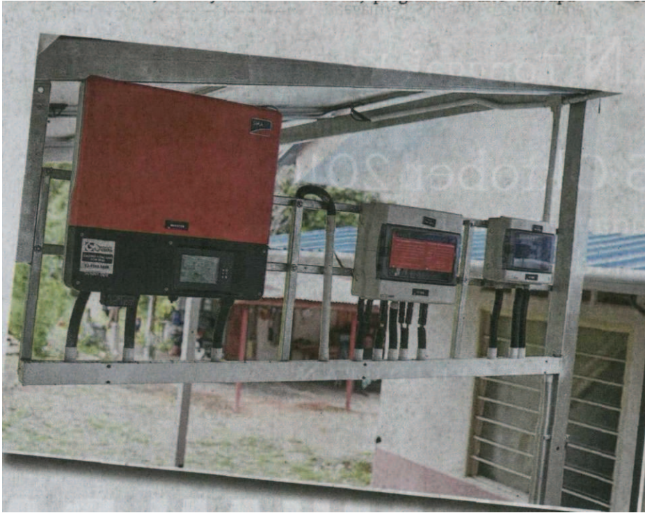
PERALATAN seperti inverter, kotak kombinasi dan kotak fius yang dipasang untuk sistem penjanaan tenaga solar.
