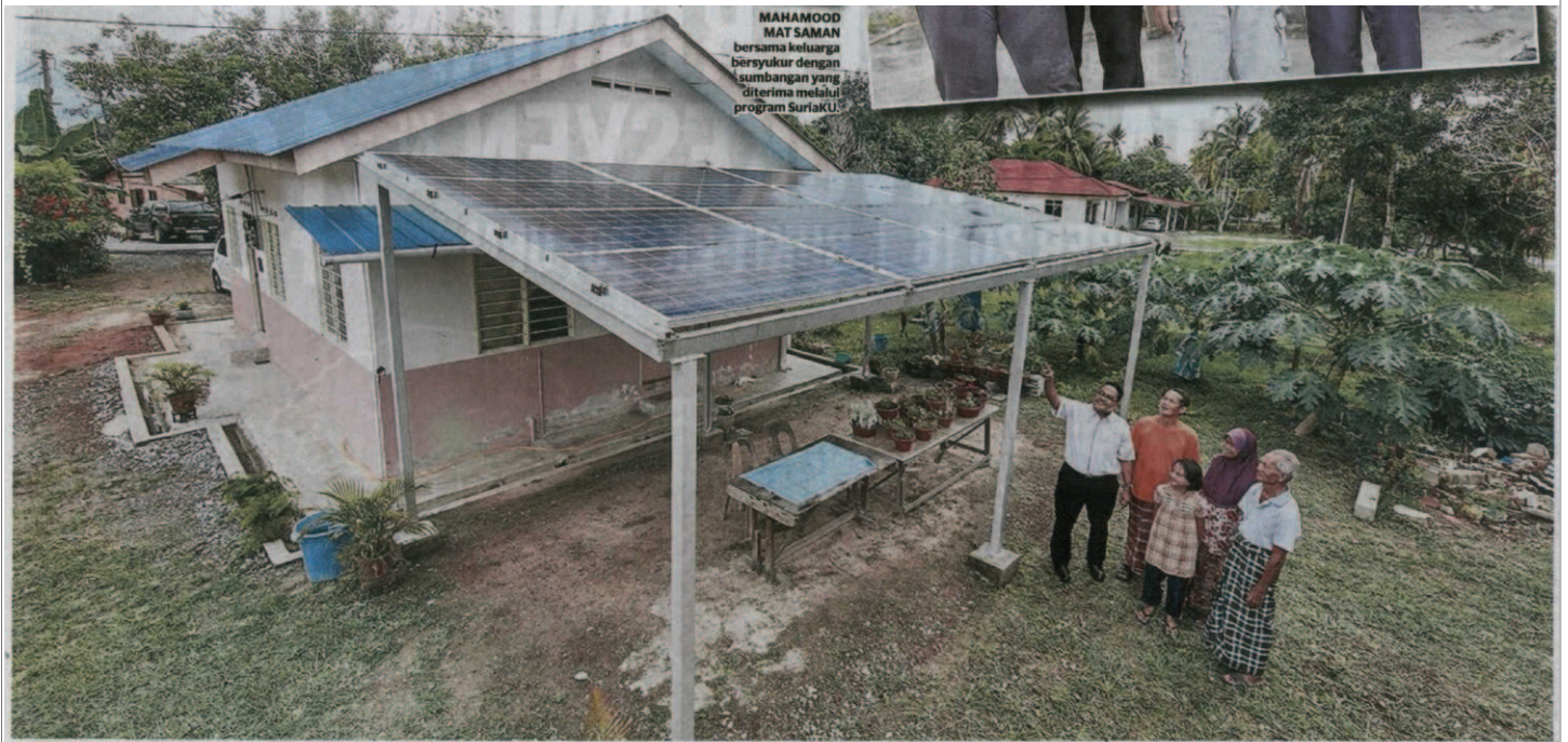
BUMBUNG-BUMBUNG rumah rakyat kumpulan B40 dipasang panel solar PV (fotovolta) untuk menjana tenaga elektrik yang kemudiannya dijual secara terus kepada Tenaga Nasional Berhad (TNB).
