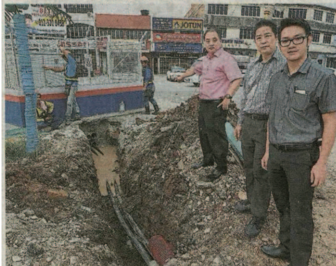
■黄瑞林（左）巡视电源转接站工程进度，右起为颜健荣及黄亚祥。
