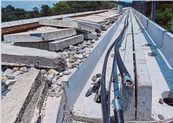
Jurutera QAQC China Communications Construction (CCC) ECRL bersama Pegawai Keselamatan dan Kesihatan CCC ECRL menunjukkan kabel yang dipotong di landasan ECRL Kampung Luit, Maran.
