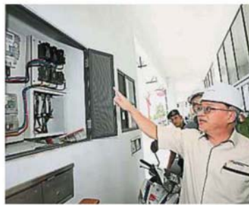
扎吉安指其中一家楼上单位绕开电表偷电, 以挖比特币。(高建业摄)
