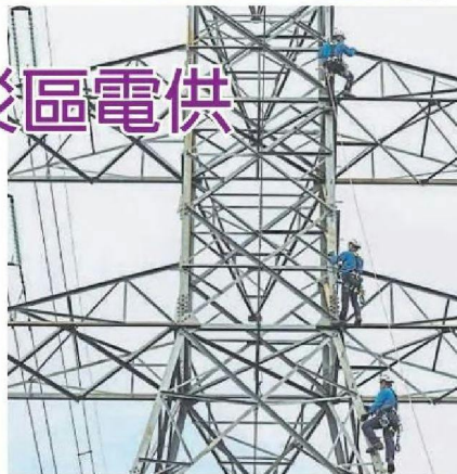
■国能切断部分受灾地区的电力供应，以确保居民安全。
