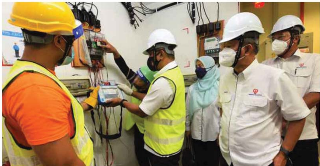
TAKIYUDDIN (dua, kiri) mencuba ujian kejituan Smart Meter menggunakan Portable Test Set (PTS) sambil diperhatikan Hasan Arifin (dua, kanan) dan Baharin (kanan) ketika lawatan di tempat latihan pemasangan Smart Meter di ILSAS, Bangi.
