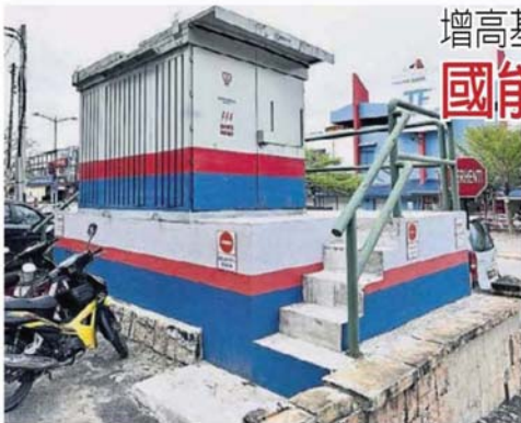
■国家能源（国能）在有潜在风险发生水灾的地区，增高变电所的平台，为雨季做好准备。
