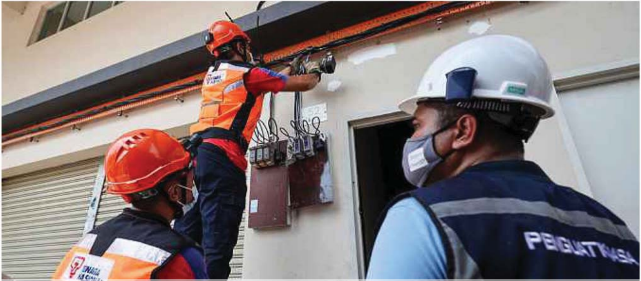
KAKITANGAN Tenaga Nasional Berhad (TNB) memotong penyambungan elektrik yang digunakan secara haram bagi menjalankan perlombongan bitcoin di sebuah premis perniagaan dekat Valdor Simpang Ampat.
