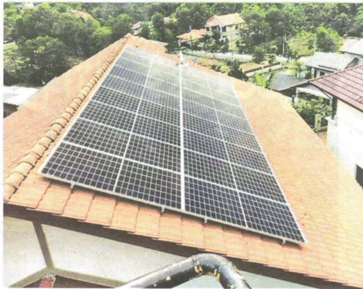
KERJA-KERJA pemasangan panel solar di atas bumbung rumah.
