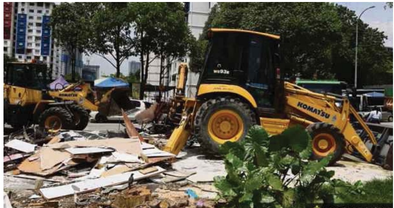
DBKL merobohkan gerai penjaja tanpa kebenaran di Jalan Pantai Permai, Projek Perumahan Rakyat (PPR) Kerinchi, Kuala Lumpur, kelmarin.
