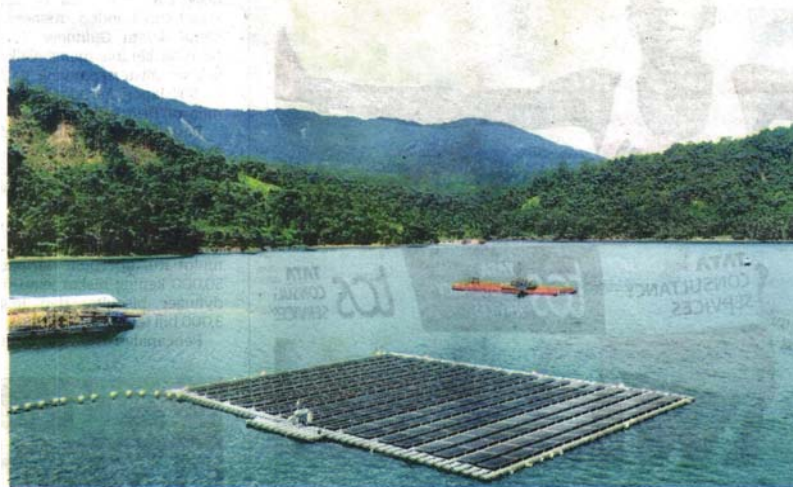
FASA satu projek solar terapung yang sedang giat dilaksanakan di Tasik Kenyir, Hulu Terengganu.
