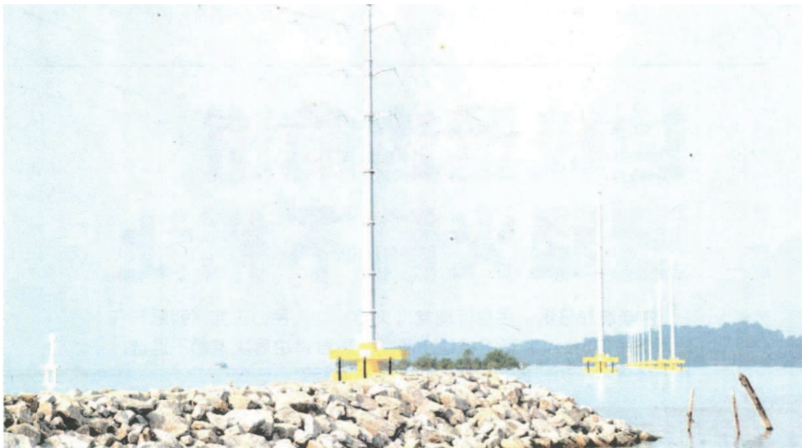
国能搭建的12座高杆电缆可提供5000伏特至13万2000伏特的电量，五屿岛居民从此摆脱电供不稳定的困扰。
