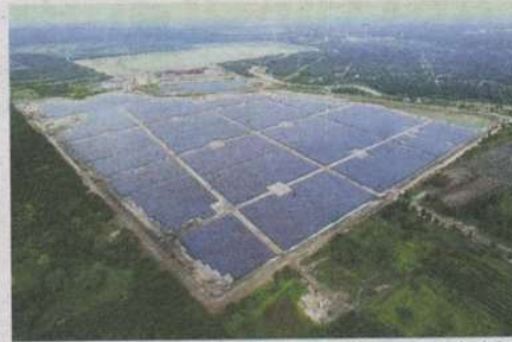
PROJEK LSS TNB di Kuala Langat mempunyai 230,000 panel solar dan kabel gantian optik bawah tanah sepanjang 10 kilometer dengan kuasa 132kV.
