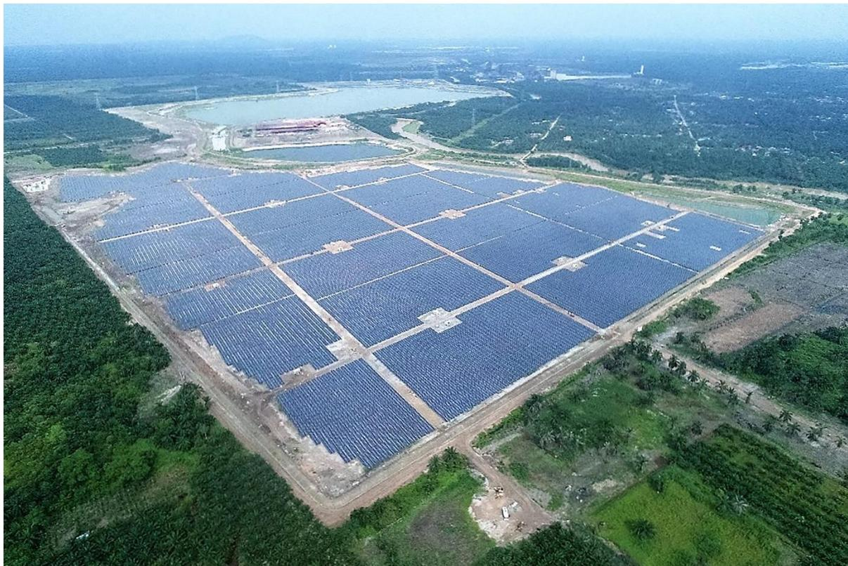
Projek solar berskala besar (LLS) Tenaga Nasional Berhad (TNB) di Sepang, Selangor dilengkapi dengan 238,140 panel solar dengan kapasiti penjanaan sehingga 50 megawatt (MW).
